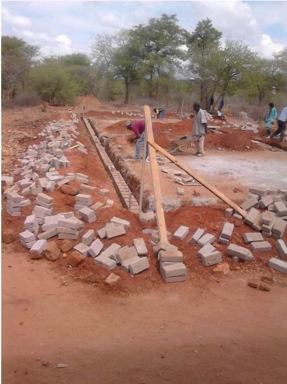
Ein Bild vom neuen Schulgebäude - kurz nach Baubeginn.
