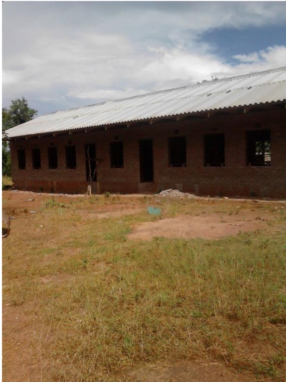
Das Dach ist fertig eingedeckt. Blick auf die Gebäude-Vorderseite.
