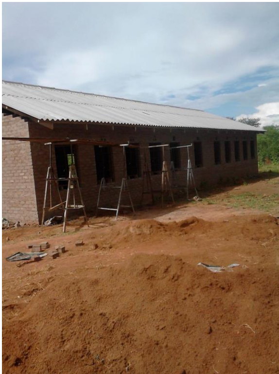
Rückseite des Gebäudes.
